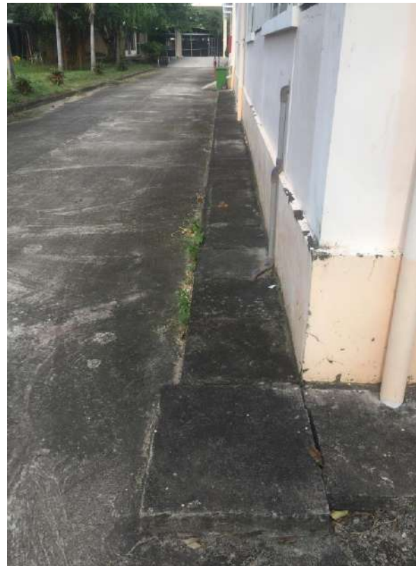
Hình PLI.6. Hồ ga và đường cống thu gom nước mưa
