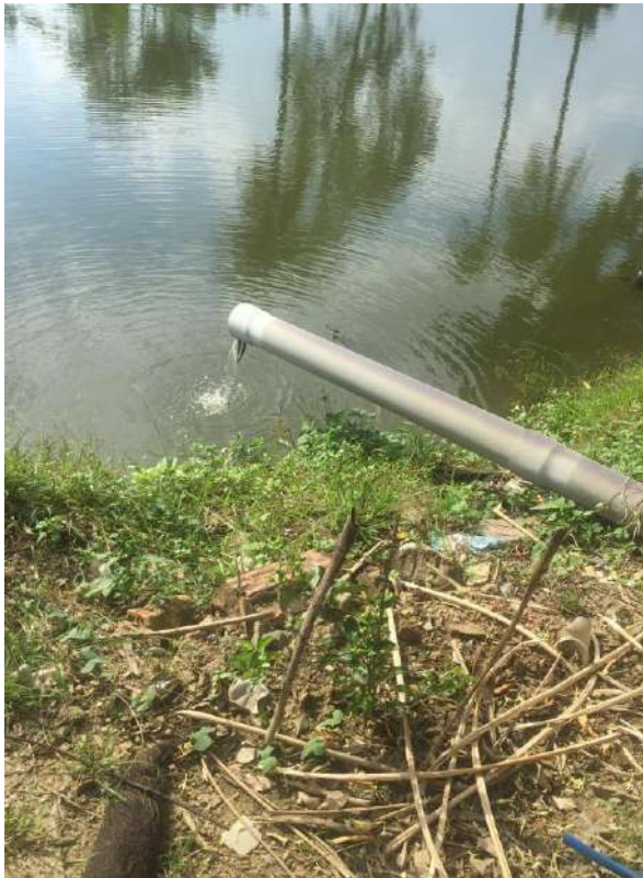
Hình PLI.3. Vị trí xả nước thải sau xử lý thoát ra ao sinh học; vị trí thoát nước từ ao sinh học ra nguồn tiếp nhận trực tiếp hệ thống kênh mương nội đồng
