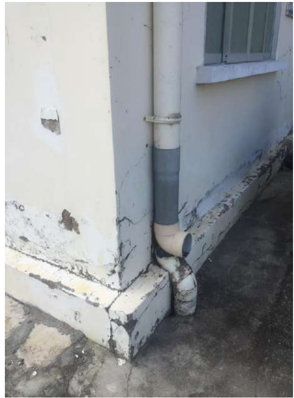
Hình PLI.7. Hố ga và đường ống thu gom nước mưa
