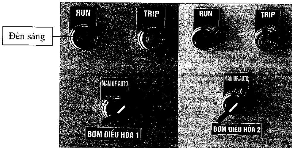
Hình 5: Chế độ hoạt động bình thường của hai bơm nước thải bể điều hòa (khi phao LS01 tại bể điều hòa báo đầy bơm nước thải WP01-1 hoạt động, đèn báo RUN màu xanh sáng; bơm WP01-2 lúc này không hoạt động. Sau 4 giờ hệ thống tự động chuyển sang cấp nguồn cho bơm WP01-2 hoạt động, lúc này bơm WP01-1 chuyển sang chế độ chờ).
