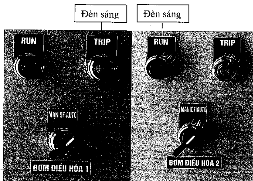
Hình 6: Chế độ hoạt động của hai bơm nước thải bể điều hòa khi gặp sự cố (Khi Bơm nước thải 1 đang hoạt động gặp sự cố, đèn báo TRIP màu vàng sáng còi hú và hệ thống tự động chuyển sang bơm nước thải 2 sau 5 giây; bơm nước thải 2 hoạt động đèn báo RUN màu xanh sáng).
