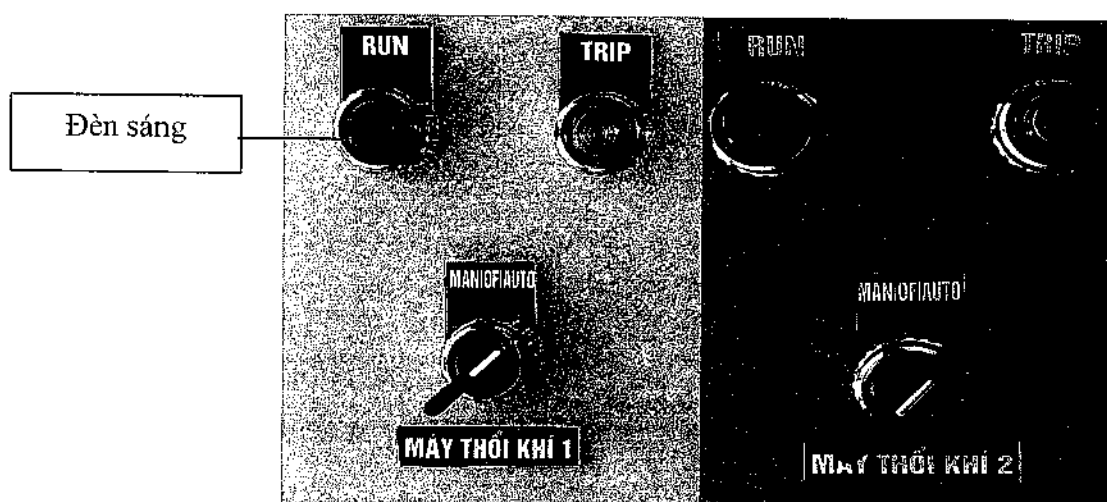
Hình 7: Chế độ hoạt động bình thường của hai máy thổi khí (Máy thổi khí 01 đang hoạt động đèn báo RUN màu xanh sang, máy thổi khí 2 không hoạt động).
